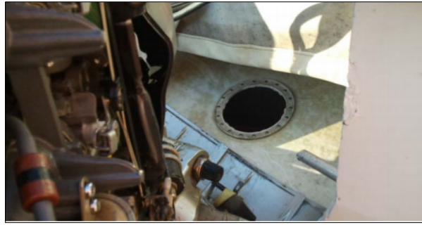
Figur 2.5: Locket till inspektionsluckan saknas vid bärgning (Transportstyrelsen, 2011).
